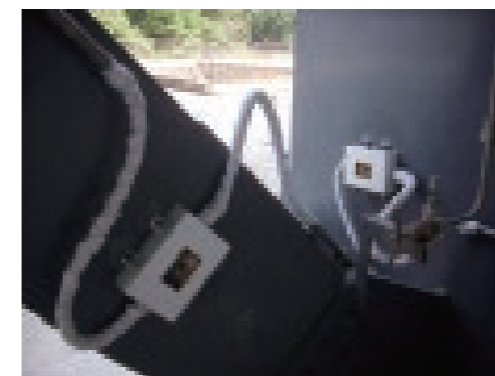
钢结构表面应变监测
